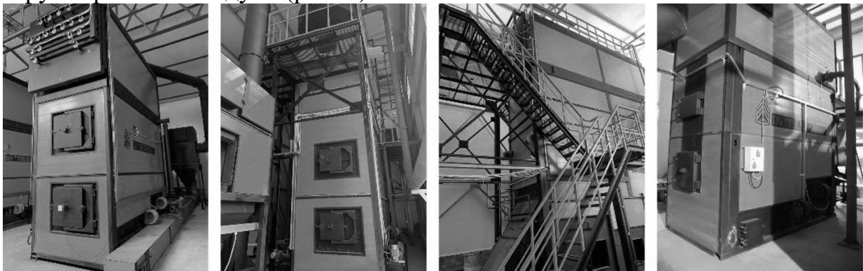
Рис 3. Модульная группировка оборудования биотопливных котельных
